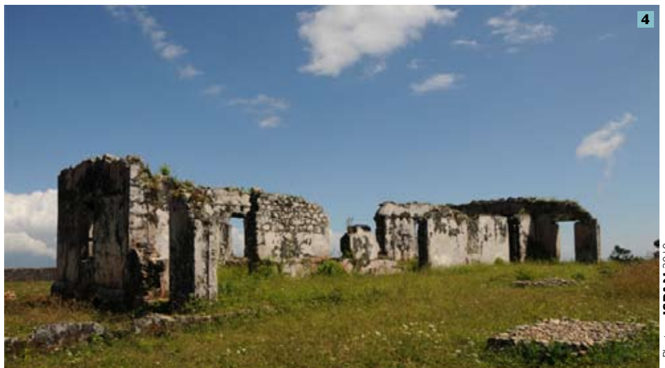
1. Les citernes de l'habitation caféière Dion • 2. Mesurage des ruines de l'habitation caféière Sabourin • 3. Mesurage des ruines de l'habitation caféière Latour • 4. Ruines de la grand-case de l'habitation caféière Dion
